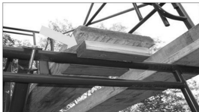
تعبیه بست در دو طرف تخته‌ها باعث افزایش ایمنی می‌گردد
